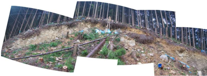
Slika 15 - Tipični izgled čela klizišta, vidljive su glavna i bočne škarpe čela klizišta
